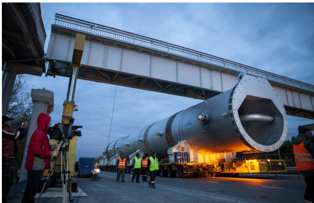
Рис. 3. Проезд под пешеходным мостом длиной 39 м, поднятом на высоту 2 м. После проезда мост установлен на место с точностью до миллиметра [4]
