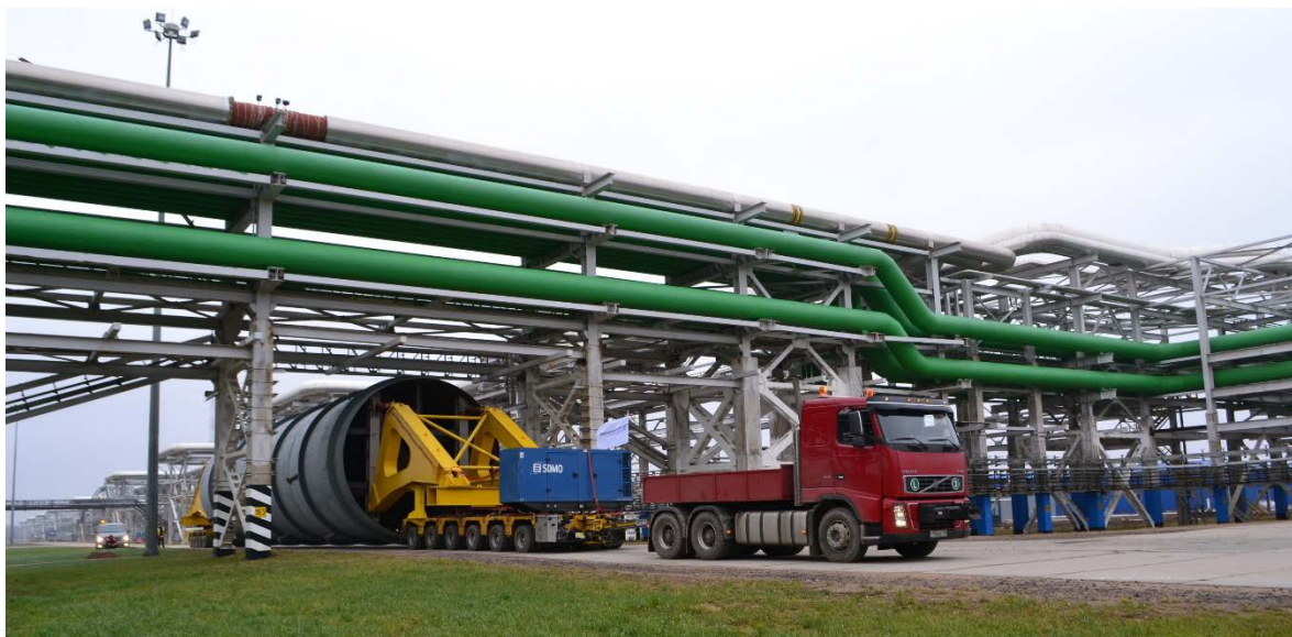
Рис. 5. Транспортировка негабаритного груза в «провисе» под эстакадами технологических трубопроводов без остановки производства нагрузки
