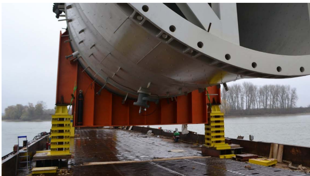
Рис. 7. Применение системы ступенчатого подъема
