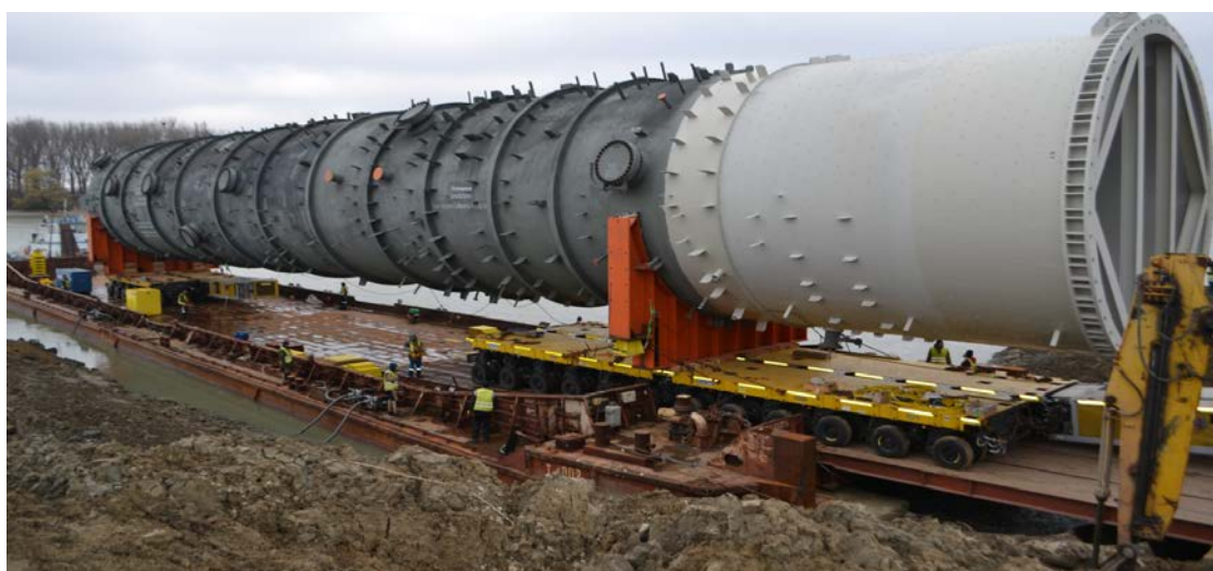
Рис. 8. Выгрузка методом Ро-Ро при опирании силового элемента баржи на причальное сооружение
