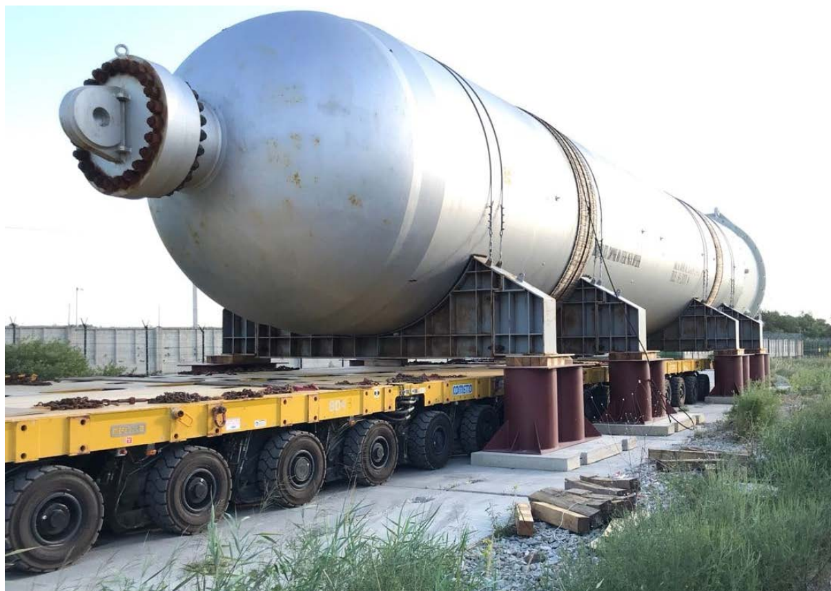
Рис. 2. Пример ПРР колонного оборудования массой 750 т бескрановым методом
