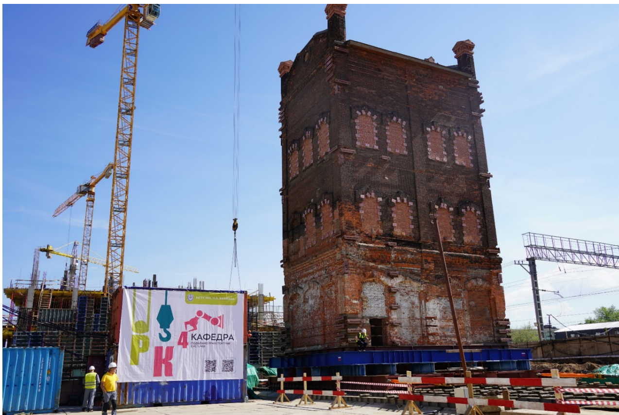
Рис.2. Передвижка водонапорной башни века на территории бывшего компрессорного завода «Борец» в Москве
